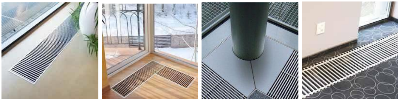
Примеры видов установки внутрипольных конвекторов:
